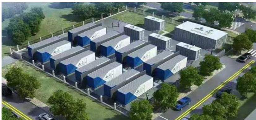
储能类重点示范项目 (中天钢铁10MW/39MWh储能电站)
