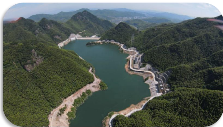
浙江长龙山抽水蓄能电站 6*350MW (三峡集团所属)
