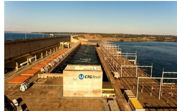
巴西伊利亚和朱比亚水电站，总装机4994MW
