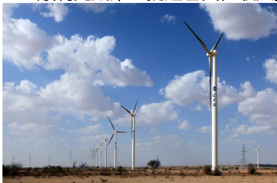
巴基斯坦风电项目，总装机148.5MW
