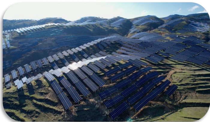
云南昭通巧家海坝240MW光伏电站
