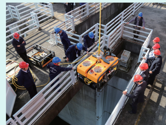
水下检修机器人即将进行水下作业
