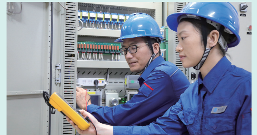
向家坝电站开展设备设施维护改造
