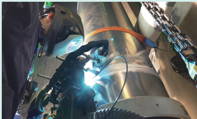
溪洛渡电站左岸 GIL 检修现场
